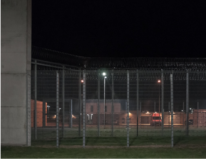
Die JSA Regis-Breitungen. Drei Sicherheitszäune trennen den Parkplatz von den Betonwürfeln der Anstalt. Foto: M. Sattler
